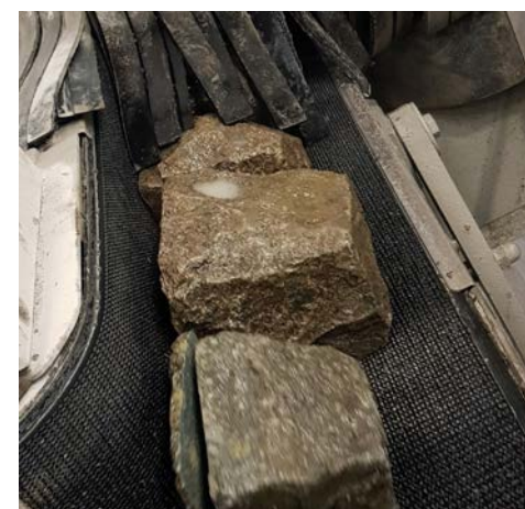
Zagen van hergebruikte kasseien - circulair bouwen.
