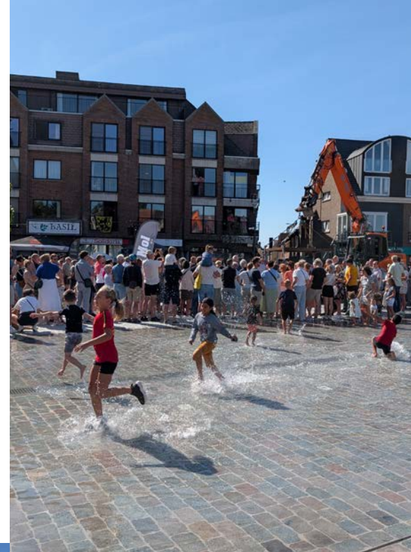
Marktplein Zele: hergebruikte kasseien, gezaagd.
